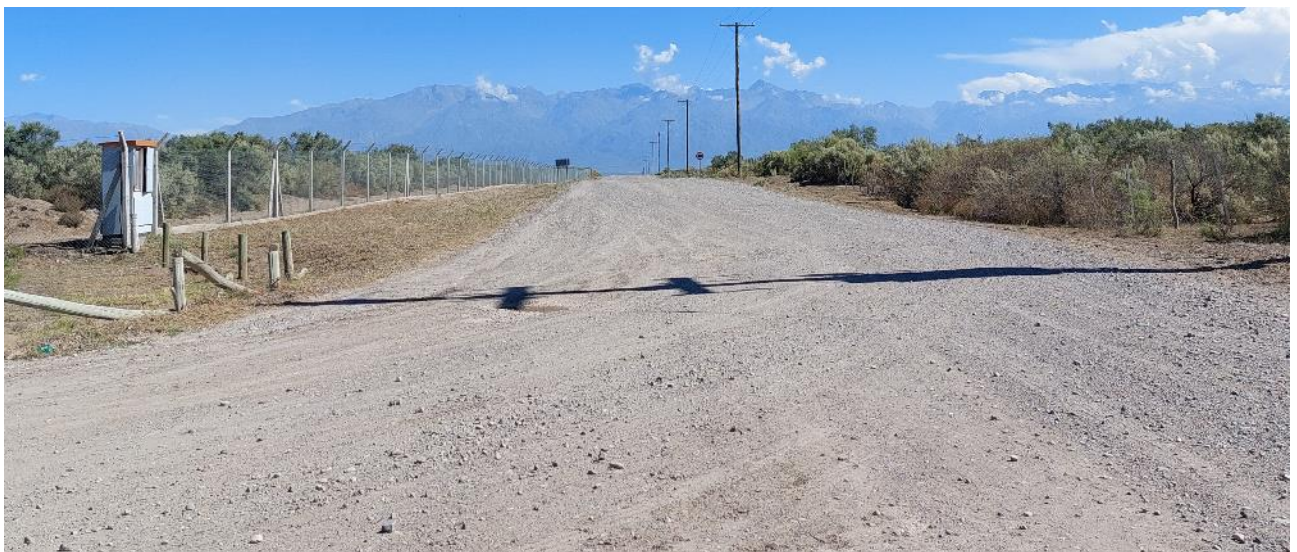
Figura 2: Vista general camino de acceso
