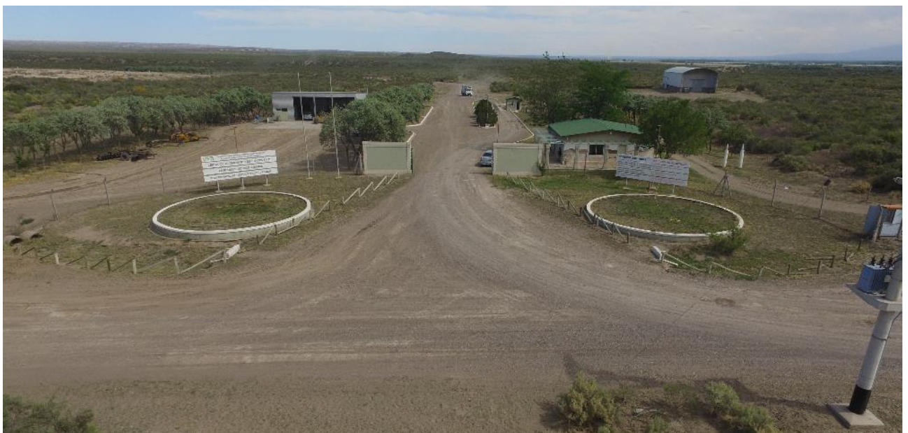
Figura 4: Vista área del acceso al CA-COINCE CÁPIZ
