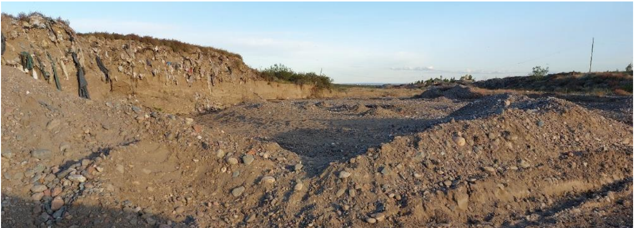
Figura 20: Vista del cauce
